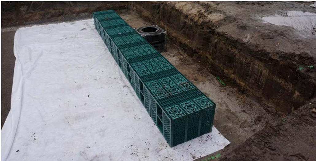
Abb. 43: Rigolenelemente in Form von Kunststofffüllkörpern beim Einbau
